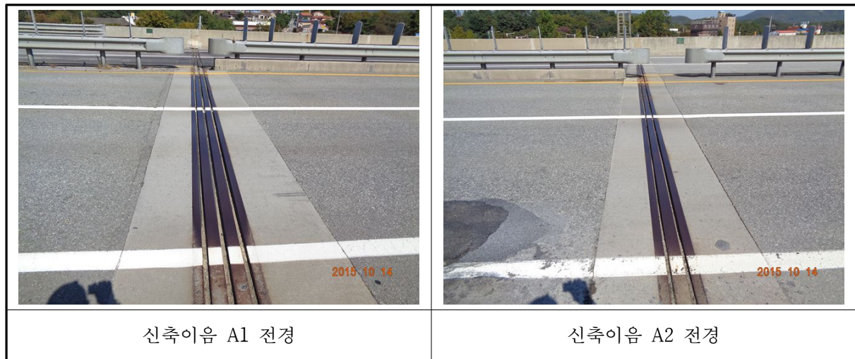
〈사진 3.8〉 신축이음 전경
