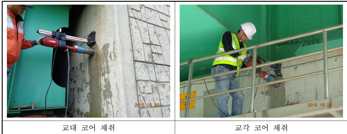
〈사진 3.21〉 압축강도 시험 현황
