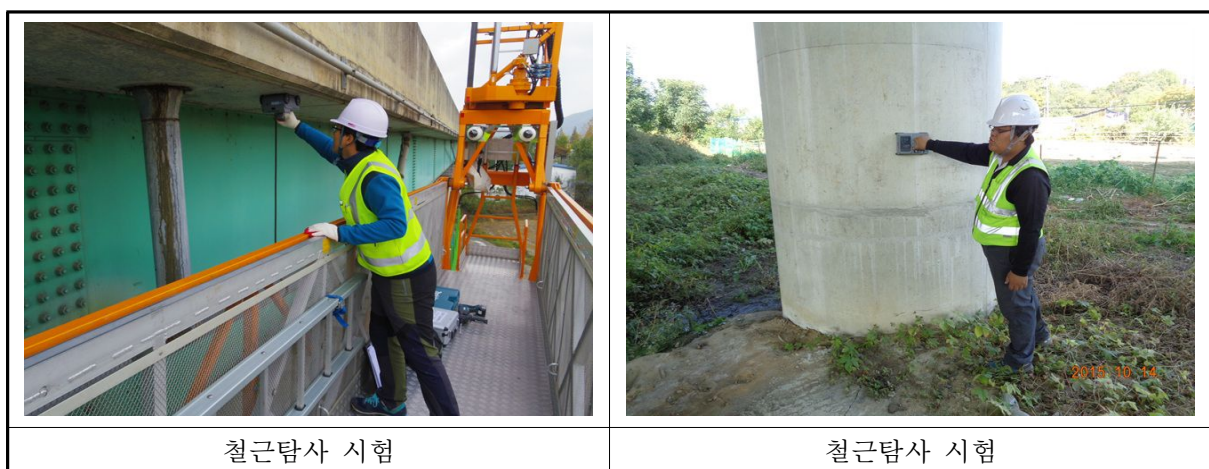
〈사진 3.22〉 철근탐사 현황
