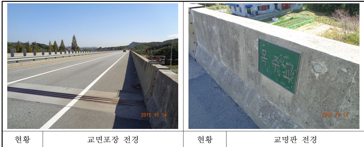
〈사진 3.2〉 교면포장 전경
