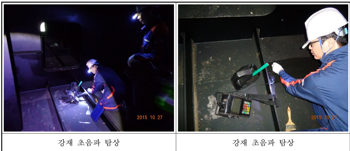
〈사진 3.27〉 강재 초음파탐상시험 현황
