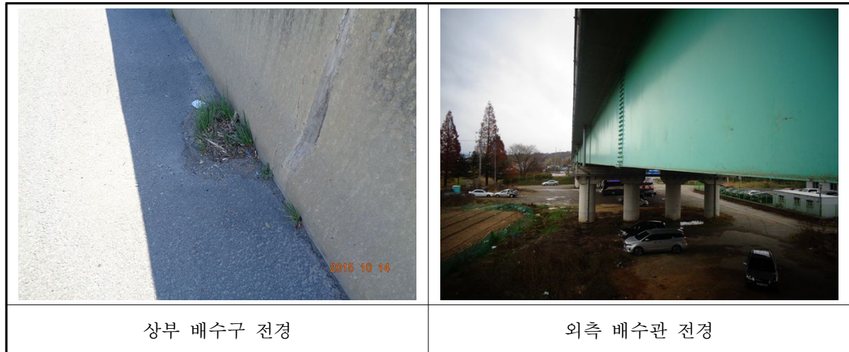
〈사진 3.6〉 배수시설 전경
