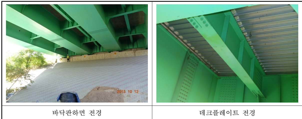
<사진 3.11> 바닥판하면 전경
