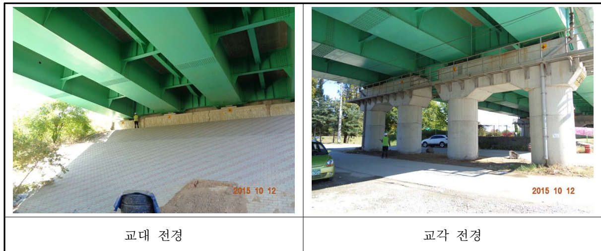
〈사진 3.17〉 교대 및 교각 전경
