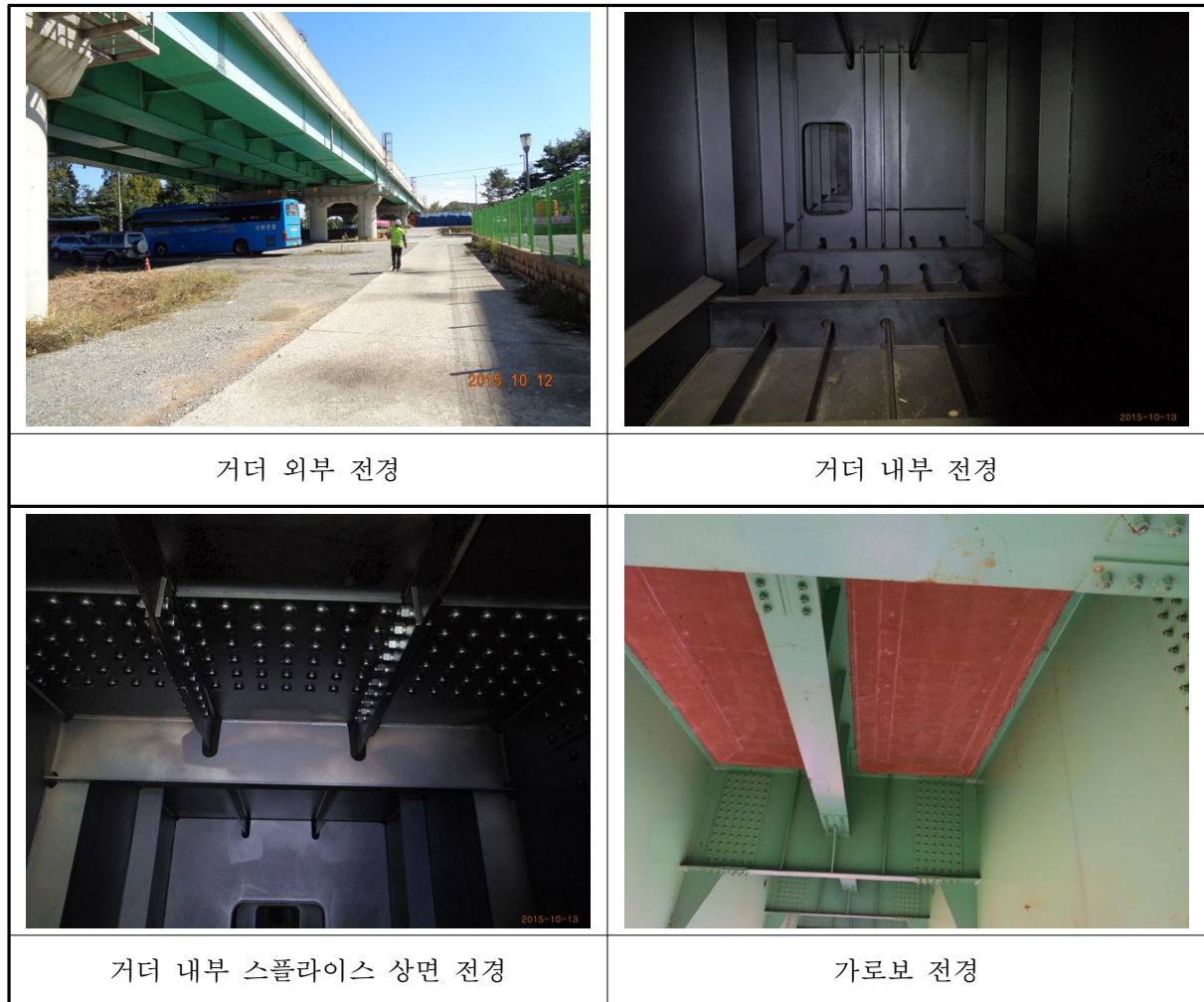
〈사진 3.13〉 거더 및 가로보 전경
