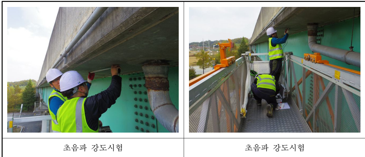
〈사진 3.20〉 초음파시험 측정 현황
