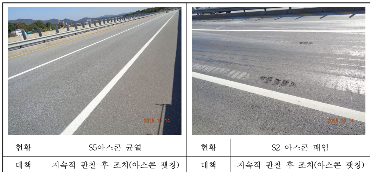
〈사진 3.3〉 교면포장 외관조사결과
