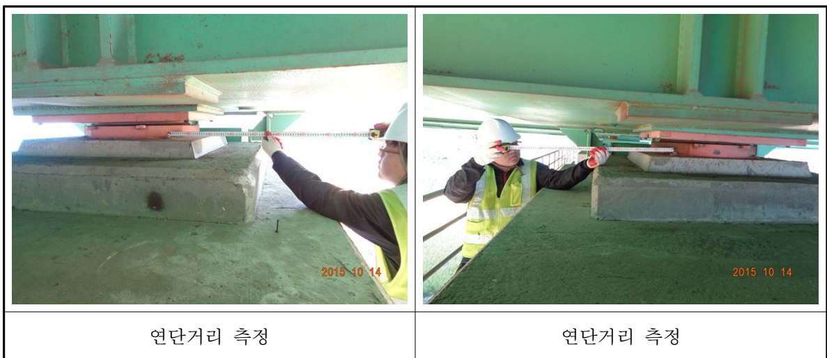
<사진 3.16> 연단 측정 현황
